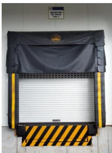
Cabezal tipo cortina con base de madera tratada, con caída de 16" hasta 20".
